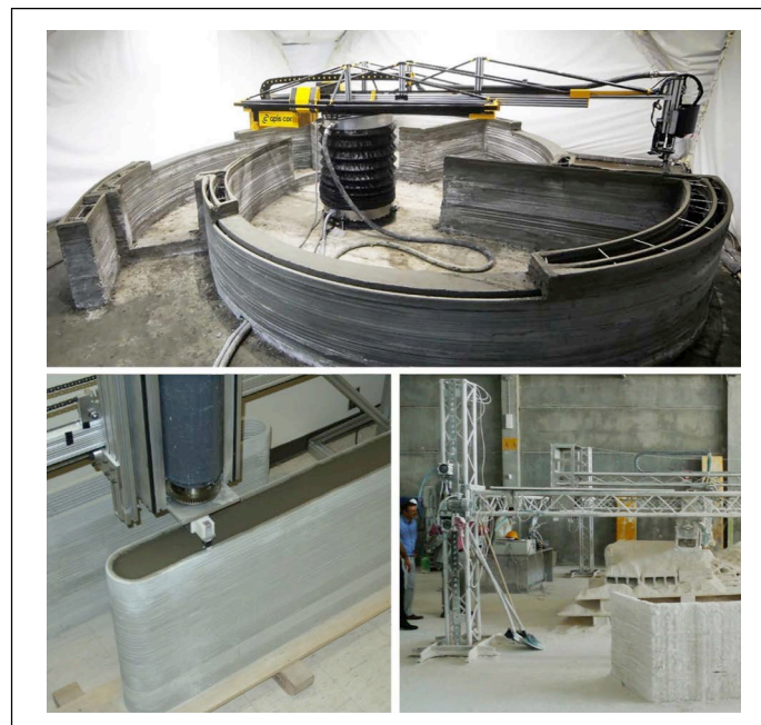
Figura 1. Tecnologías de construcción impresa en 3D (arriba: impresión de concreto, abajo-izquierda: elaboración de contornos, abajo-derecha: impresión D-Shape). Fuente: Ghaffar, Corker, y Fan (2018) y Ma, Wang, y Ju (2018)
