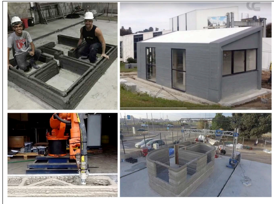
Figura 3. Experiencias de construcción impresa en 3D en Latinoamérica y España (Arriba-izquierda: Construcción de Casa 3D, Brasil; arriba derecha: Conconcreto, Colombia; abajo-izquierda: HausDrucker, Argentina; abajo-derecha: BeMore3D, España). Fuente: sitios web ( https://www.facebook.com/pages/3D-Home-Construction , https://conconcreto.com/impresora-3d/ , https://www.youtube.com/watch?v=ASTwjgs7jKw , https://bemore3d.com/ )
