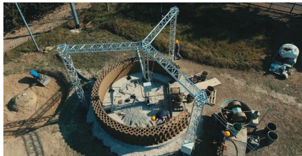
Figura 2: Sistema cilíndrico de construcción impresa (Crane, 2019).
