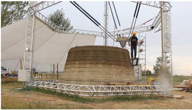
Figura 3: Sistema paralelo de construcción impresa (Big Delta, 2017).
