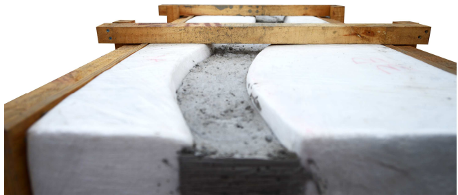
Figura 5: Encofrado tradicional y moldes de EPS con superficies de doble curvatura seccionados con cuchillo caliente flexible CNC en 7 ejes, Departamento de Arquitectura, UTFSM, 2015.
