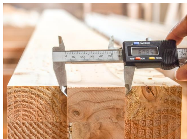
Figura 3: Verificación/corrección de tolerancias para el fresado de una espiga en viga de madera laminada.
